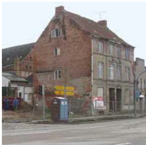
Nr. 3 vor der Sanierung
