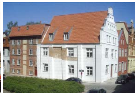
Südostansicht nach der Sanierung
