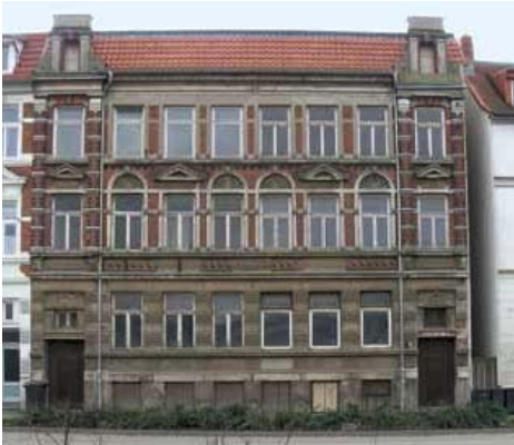
Nr. 16,17 vor der Sanierung
