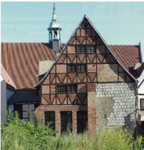
Rückfassade vor der Sanierung
