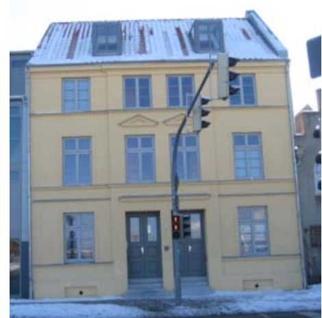
Nr. 3 Nach der Sanierung
