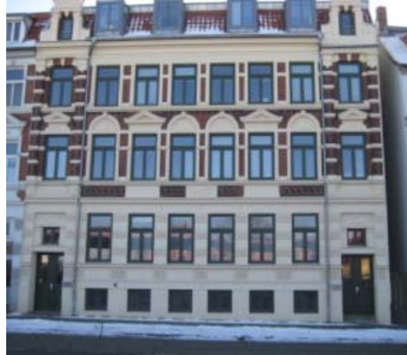
Nr. 16,17 Nach der Sanierung
